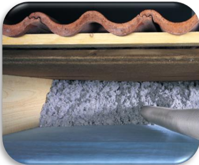
Inserción de manguera cajón de cubierta de madera.
