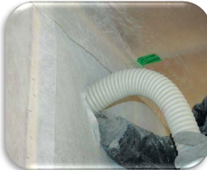
Inserción de manguera cajón entramado ligero.
