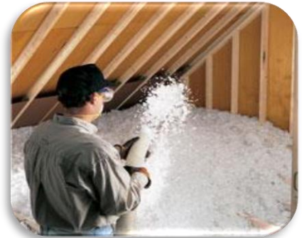
Soplado forjado de cubierta o desván no habitable.
