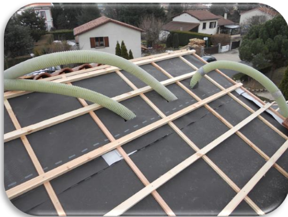
Insuflado cubierta de madera. Inserción de manguera.
